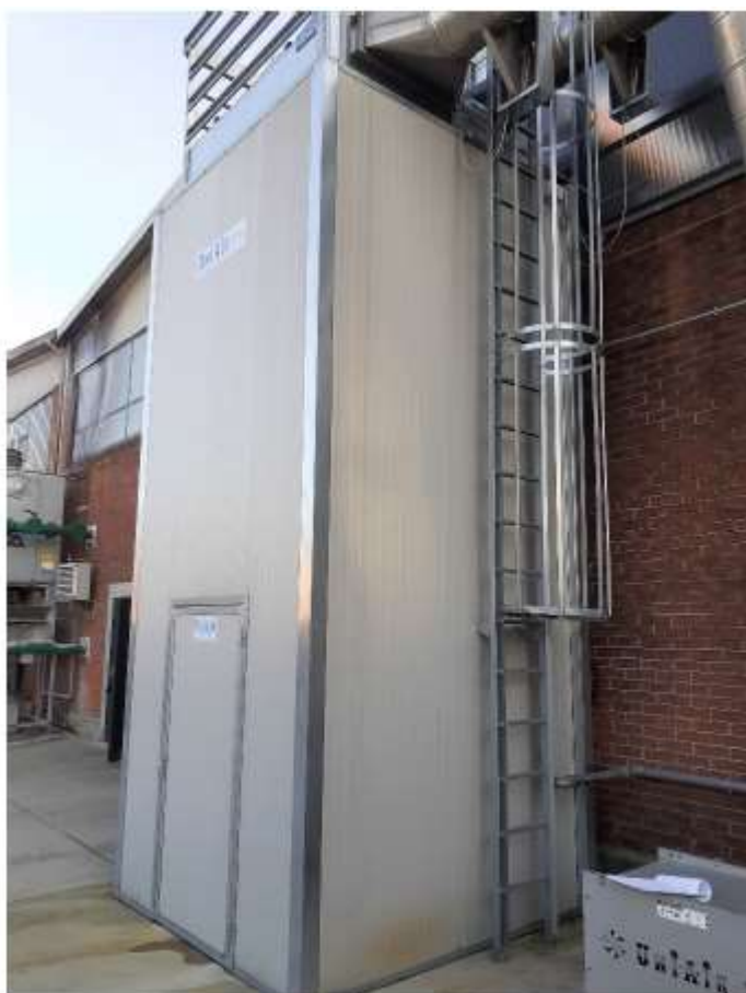
Figura 14 cabina di protezione filtro a maniche esterno
