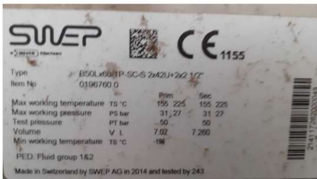
Figura 18 esempio targhetta scambiatore a piastre
