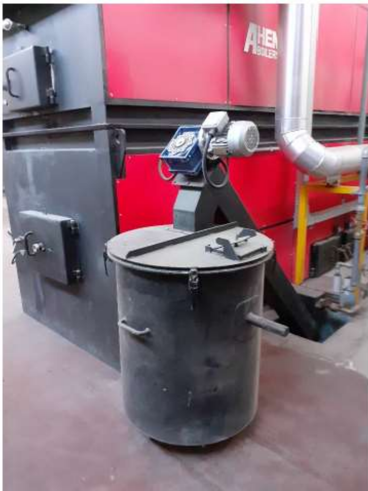
Figura 10 bidone di raccolta ceneri dalla caldaia
