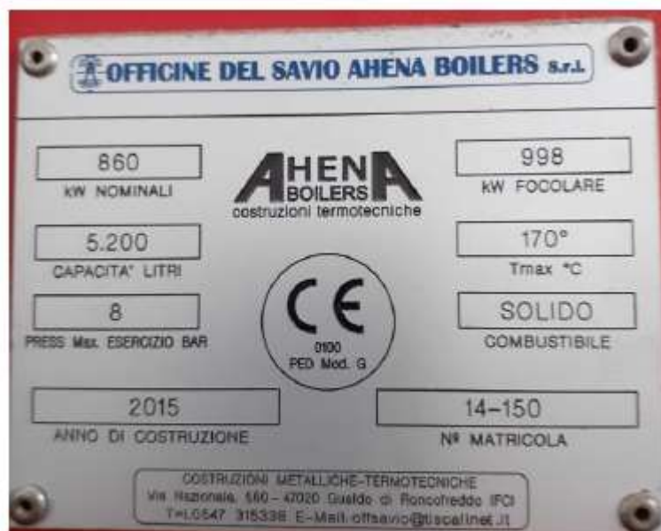
Figura 8 targhetta caldaia
