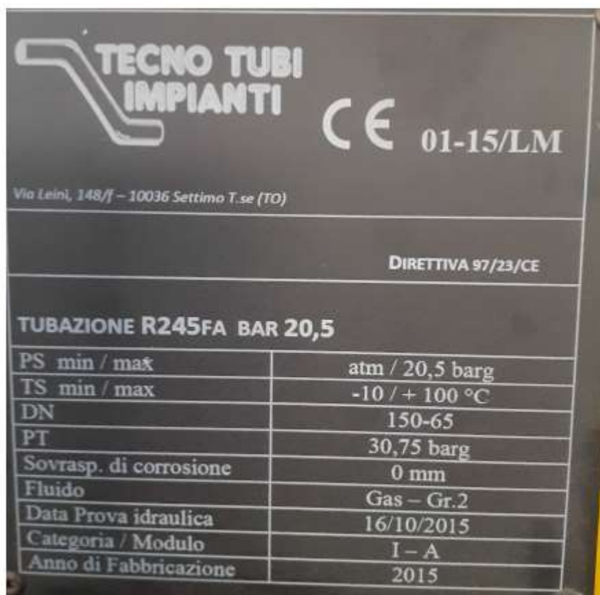
Figura 19 esempio di certificazione tubazione gas
