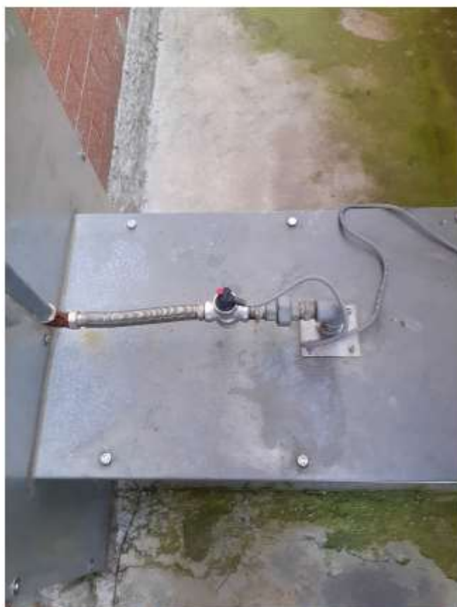
Figura 4 estintore su combustibile trasportato in coclea
