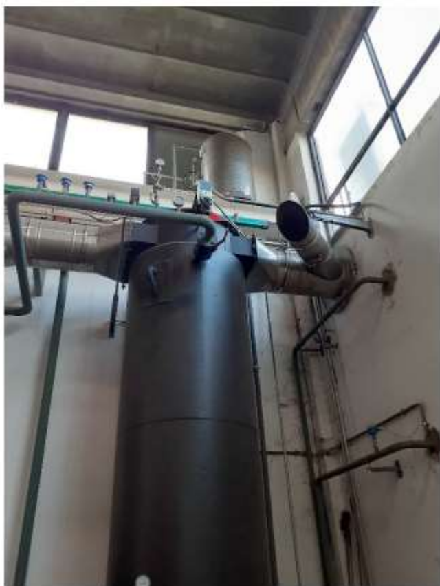
Figura 13 scambiatore di recupero di calore dai fumi
