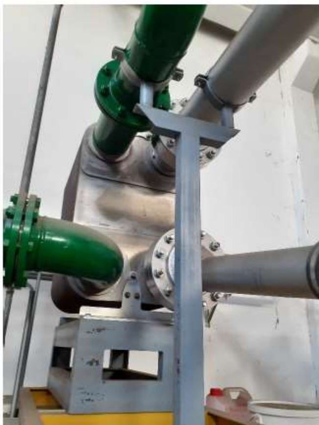
Figura 22 scambiatore/condensatore
