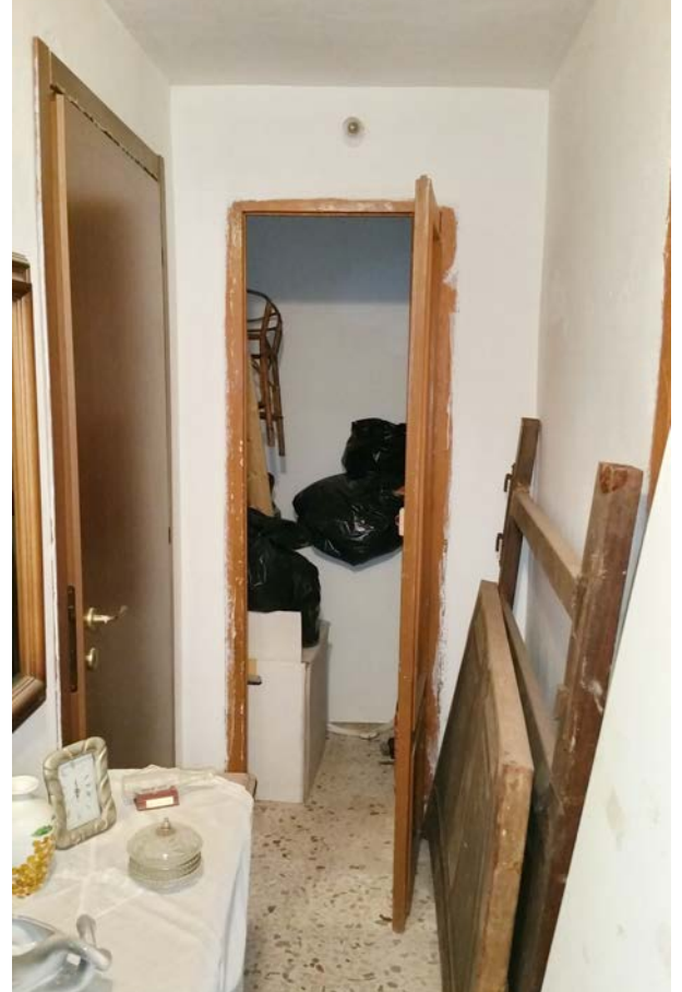
foto 18 - vista del disimpegno
