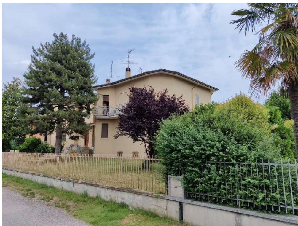
Fotografia 02 – Giardino, Vista da Via Professore Casalegno
