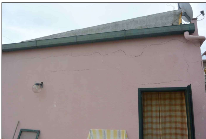
copertura del torrino scala con evidenti lesioni
