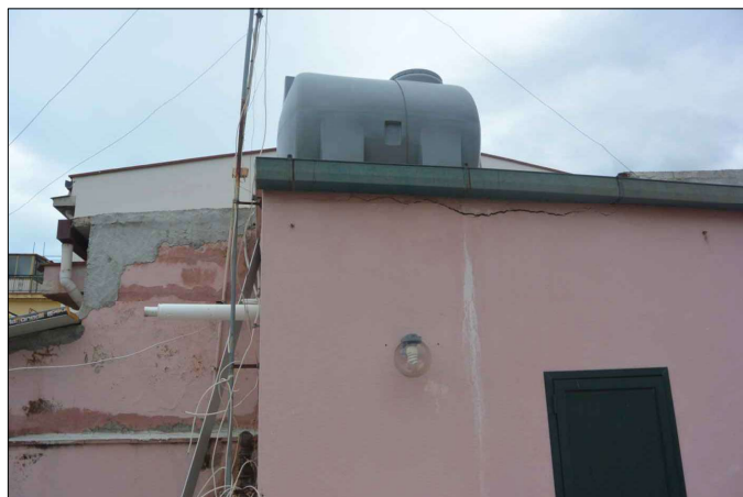
copertura del torrino scala con evidenti lesioni
