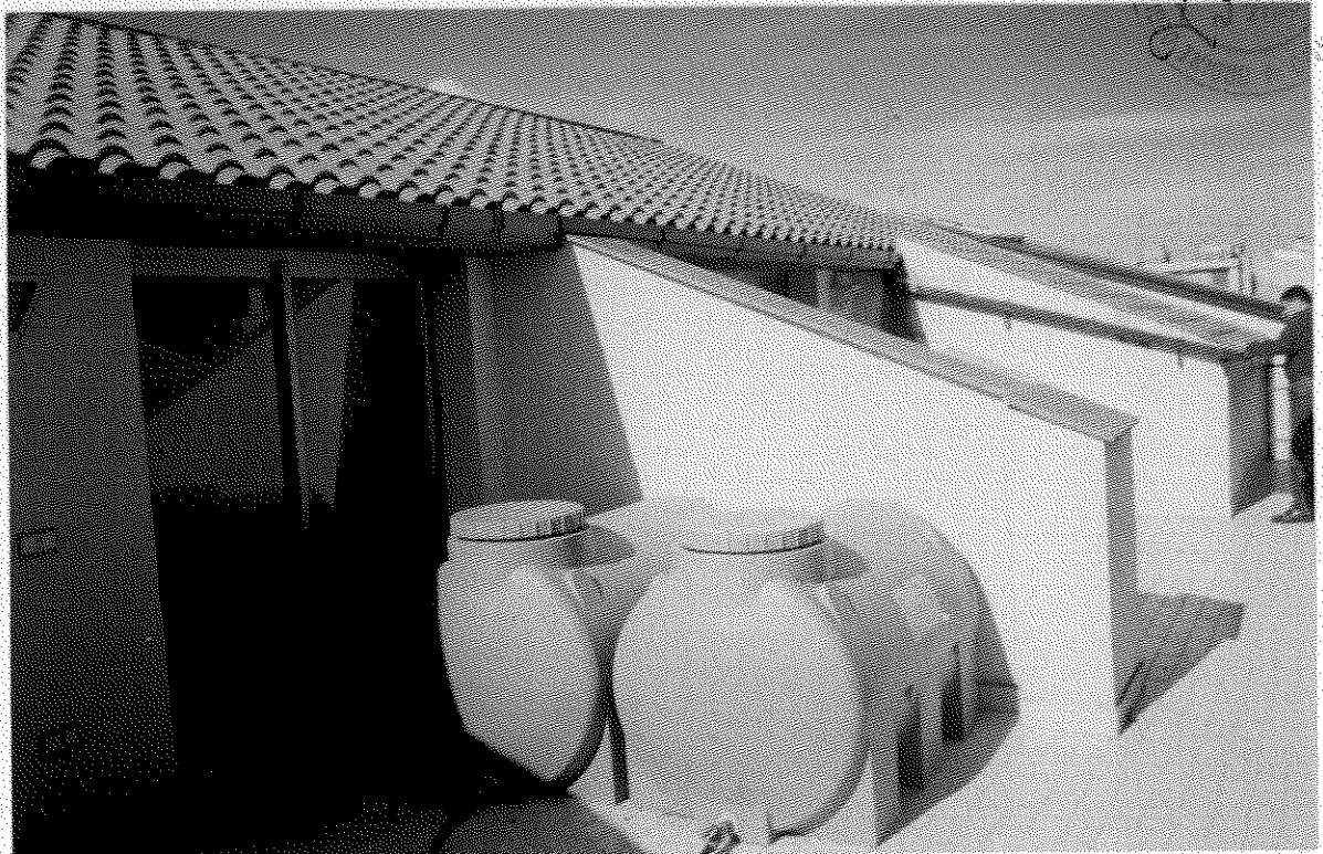
(foto n. 63) Il terrazzo e la copertura
