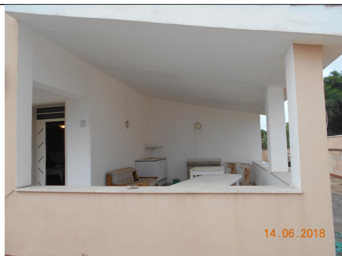
Foto n.14 - Vista della veranda
