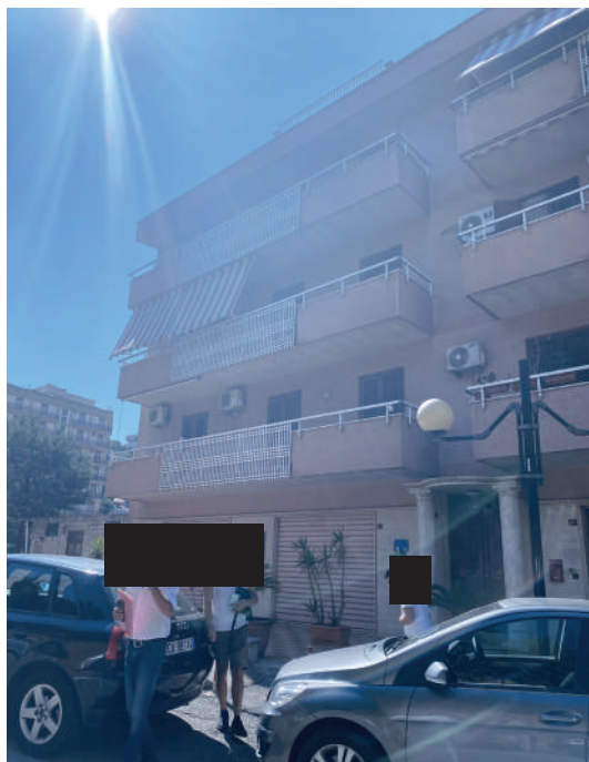
Foto 1. Prospetto principale, da cui si accede al corpo scala condominiale.
