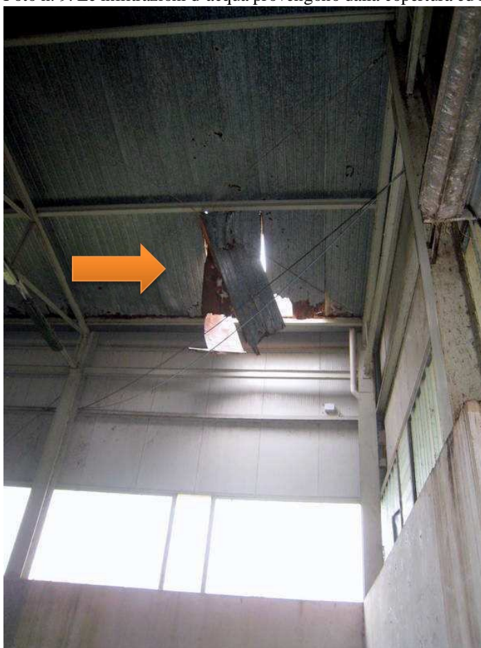
Foto n. 10. Parte dei pannelli collassati a causa della ruggine.
