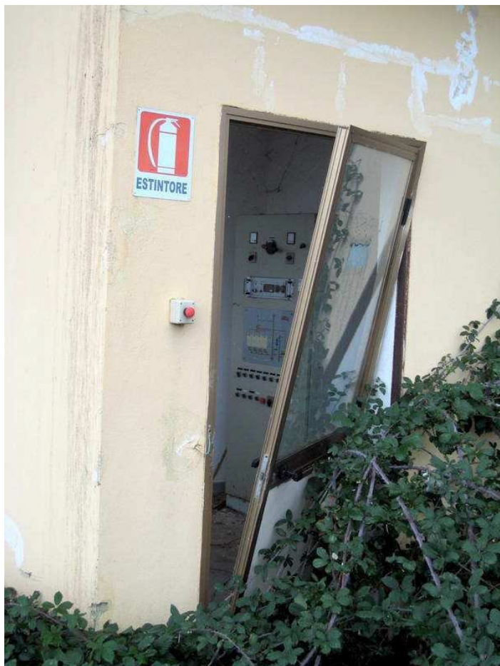
Foto n. 24. La porta è stata divelta ed il quadro di comando della pesa è vandalizzato. Foto n. 25. La fossa è piena d'acqua.
