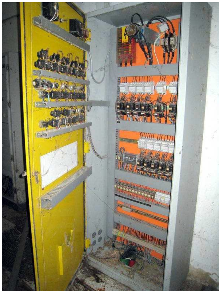
Foto n. 17 e 18. Quadri elettrici ormai danneggiati e vandalizzati.
