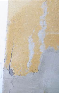
Foto 14. Immobile I1: veduta sud del balcone.
