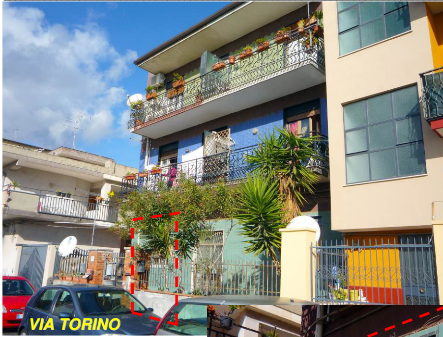
Foto 1. Veduta, dalla pubblica Via Torino (S. A. Li Battiati - CT), dell'edificio ov'è ubicato l'immobile I1 oggetto della procedura (p. terra, civico condominiale n. 51).
