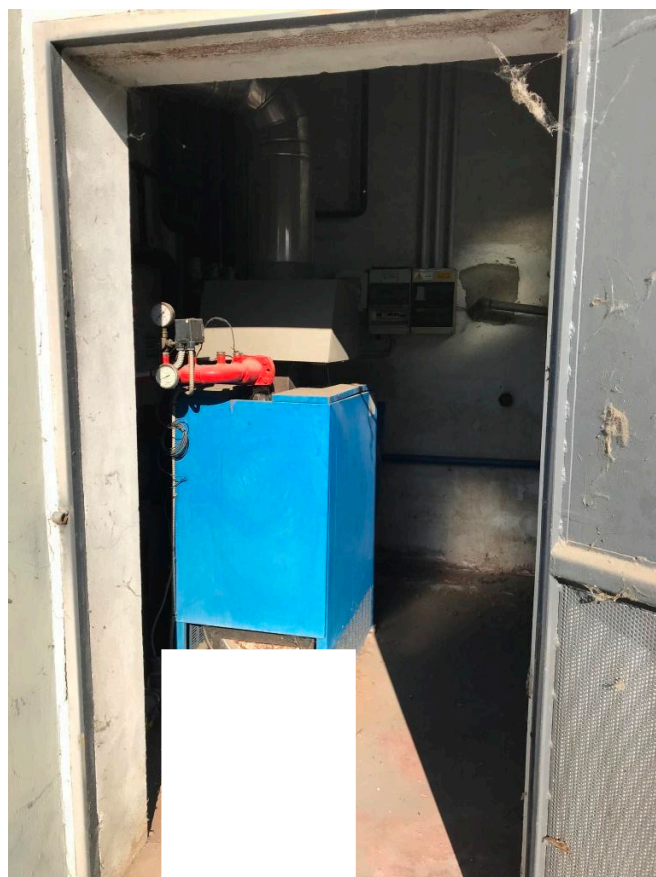
Foto n. 24 – Caldaia a basamento atmosferica
