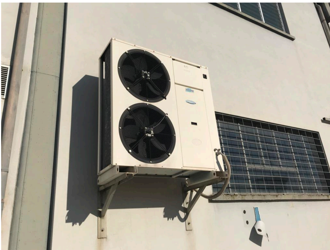
Foto n. 26 – Pompa di calore impianto condizionamento
