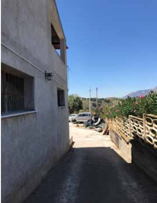
Foto 17. Area di pertinenza comune con l'immobile al piano primo.
