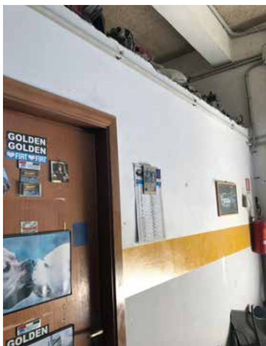
Foto 11. Locale adibito per l'attività di auto-carrozzeria.
