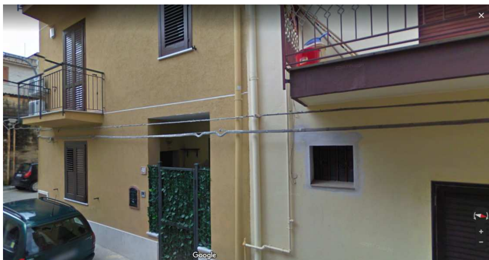
Figura 1: Portoncino in ferro di ingresso dell'appartamento sito in via Zolfari n.23 - Casteldaccia (PA)
