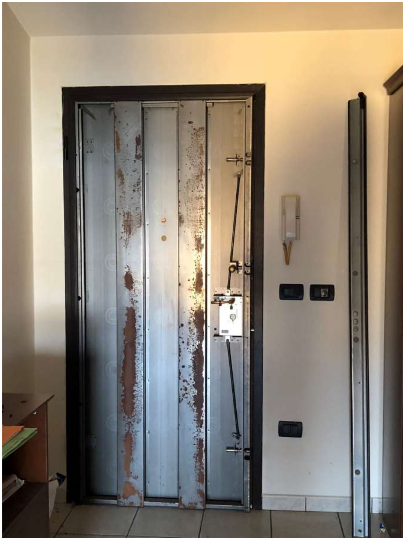
Foto 54: porta blindata (pannello di tamponamento smontato)
