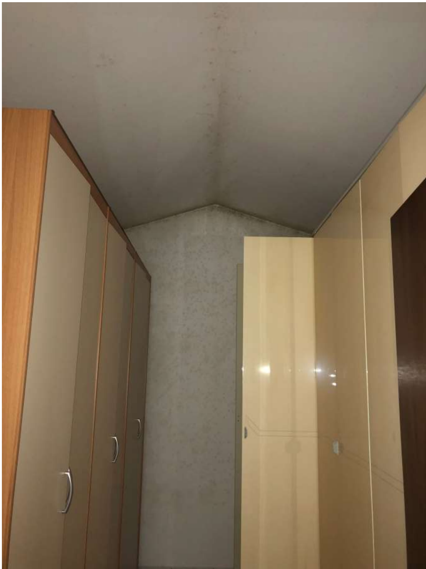
Foto 46: locale guardaroba con fenomeni di muffa alle pareti
