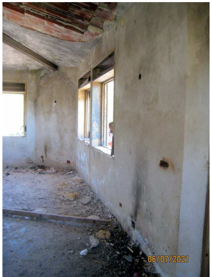
Foto n. 30-31. Ancora dettagli del tetto e delle travi in acciaio poste sui quattro spigoli a rinforzare la copertura.
