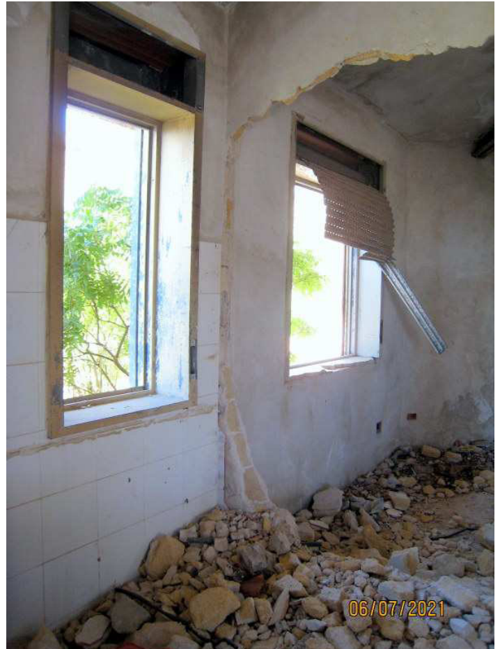
Foto n. 21. Dettaglio delle finestre e di un tramezzo abbattuto.
