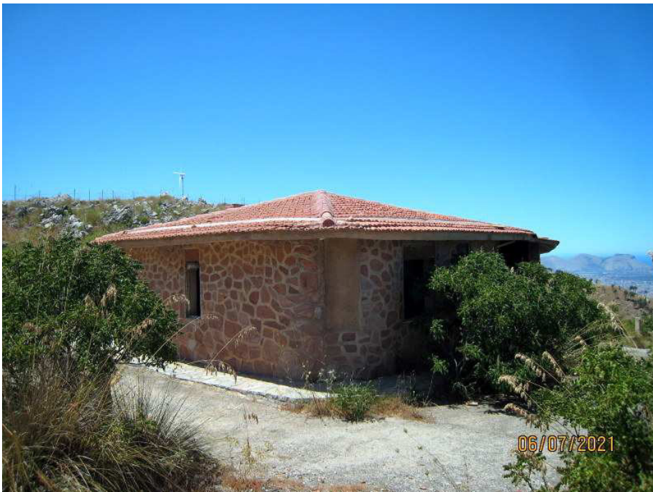
Foto n. 15. Prospetti Sud ed Est.
