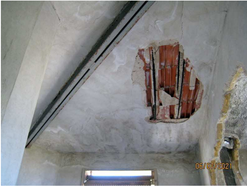
Foto n. 27-29. Tre porzioni del tetto.
