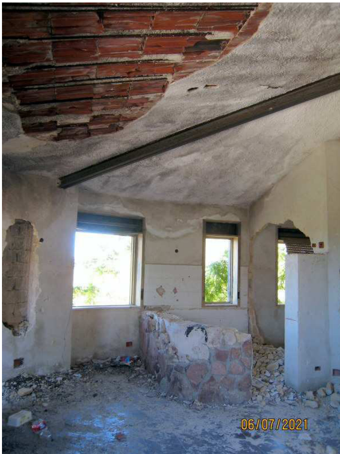
Foto n. 30-31. Ancora dettagli del tetto e delle travi in acciaio poste sui quattro spigoli a rinforzare la copertura.
