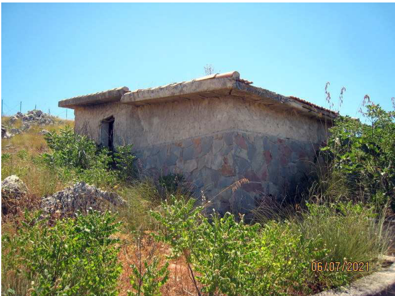
Foto n. 32. In primo piano la vasca di riserva idrica, a seguire il magazzino.
