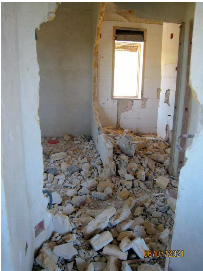
Foto n. 23. Sullo sfondo quello che rimane del bagno. abbattuto.
