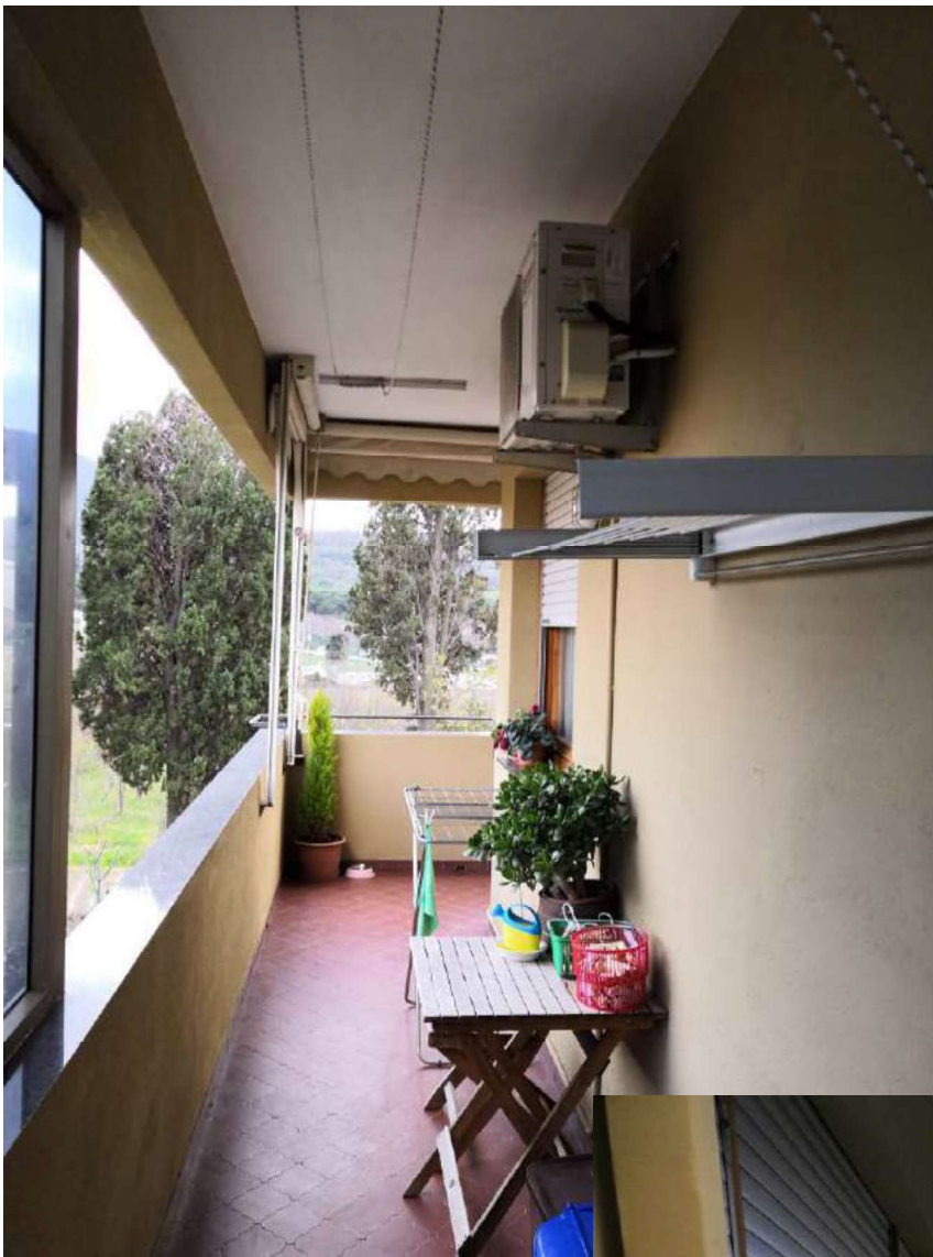
Foto 15: BALCONE – PIANO SECONDO
