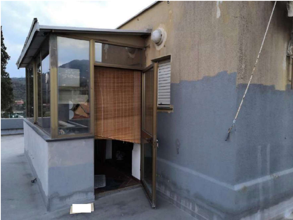
Foto 19: VERANDA – PIANO TERZO
