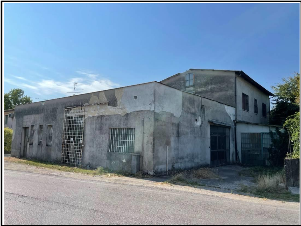
Foto 1 Prospetto da Strada San Fermo
