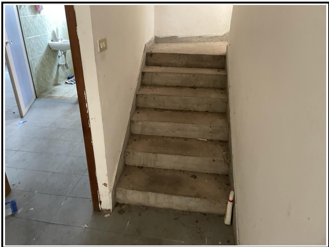
Foto 12 Vano scala di accesso al bene 4
