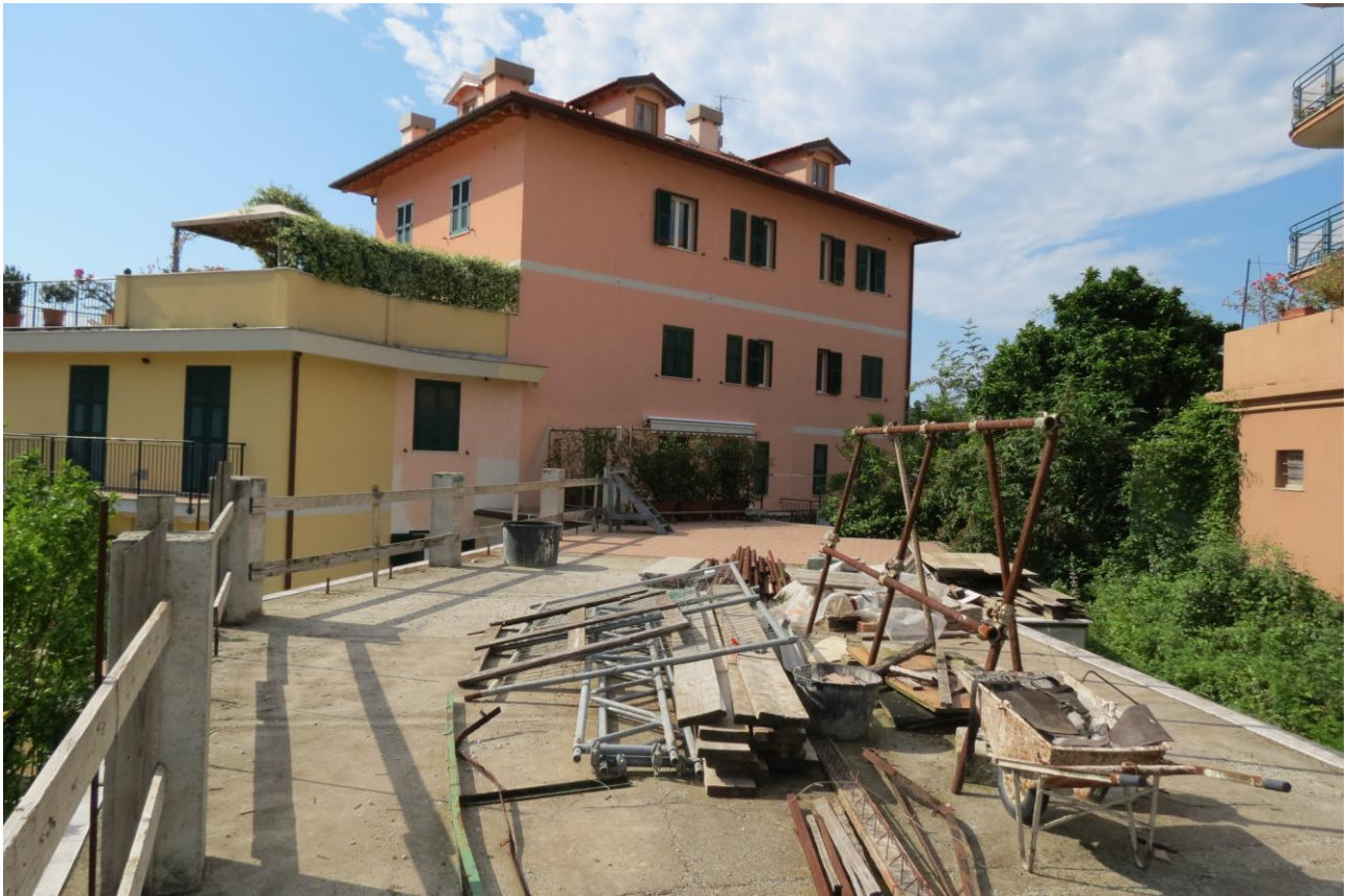
FOTO n. 3 : Il condominio fotografato dalla copertura del corpo connettivo
