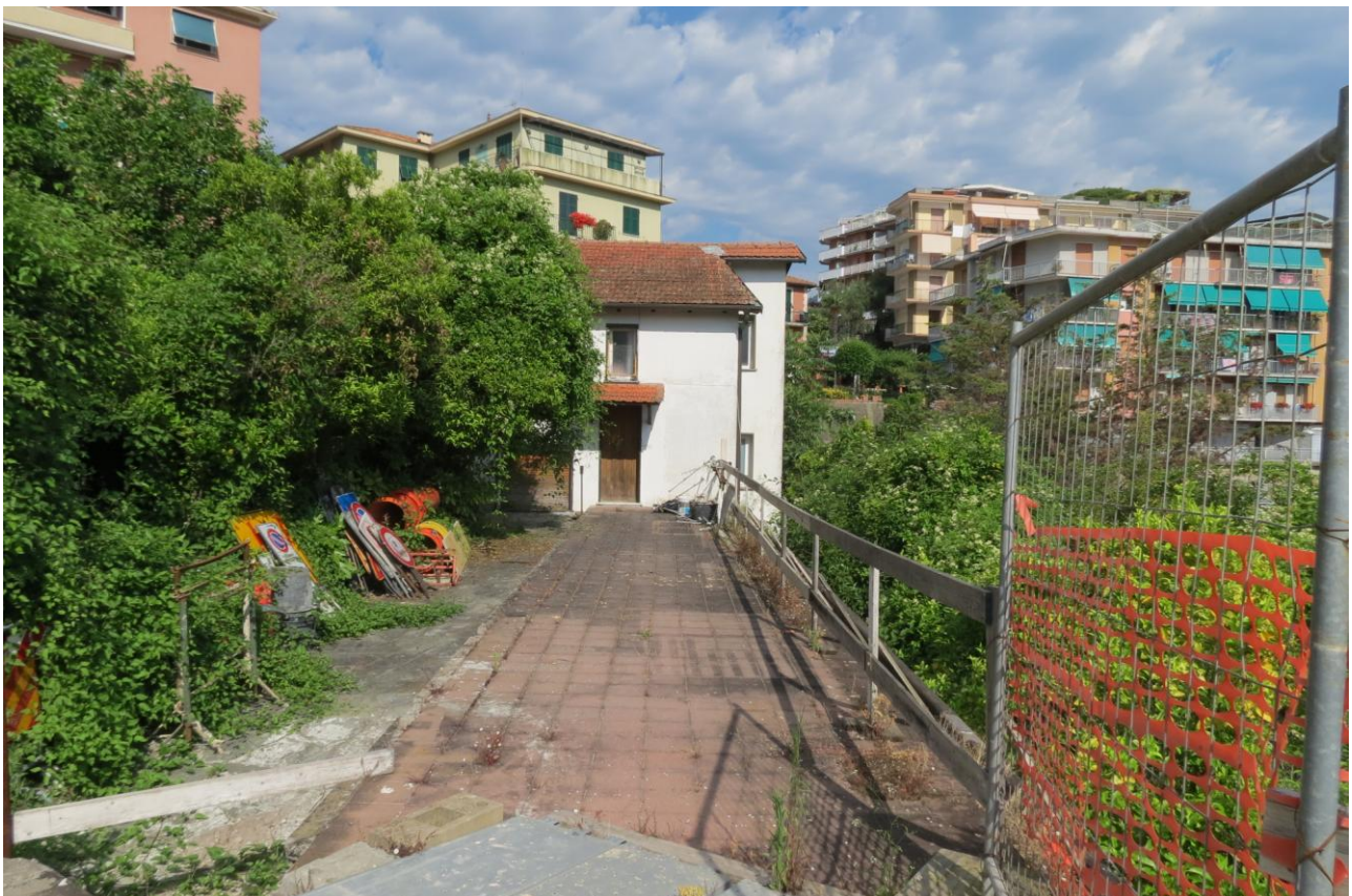
FOTO n. 4 : Il fabbricato C
