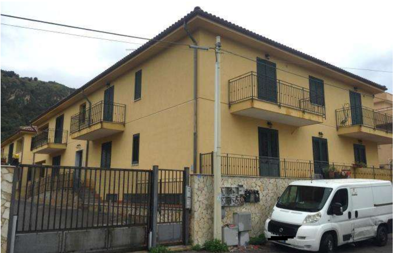
Foto n. 3 – Prospetto sulla via Sant’Elia: corpo di fabbrica A
