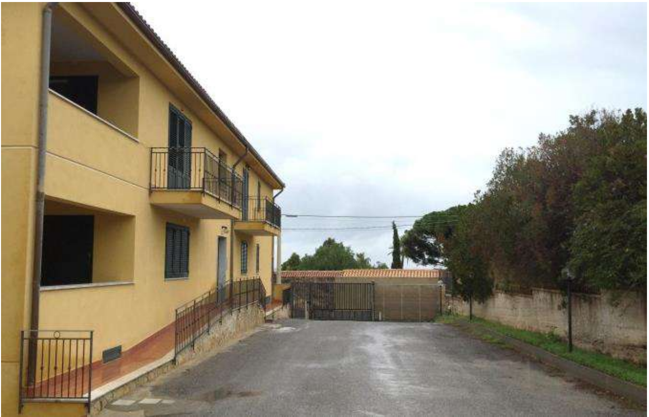
Foto n. 5 – Stradella condominiale (sub 1 b.c.n.c.)
