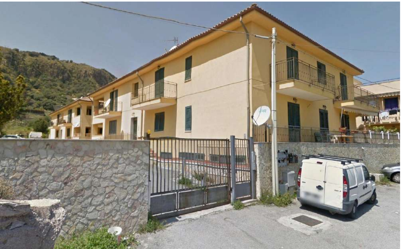
Foto n. 2 – Prospetto sulla via Sant'Elia: corpo di fabbrica A
