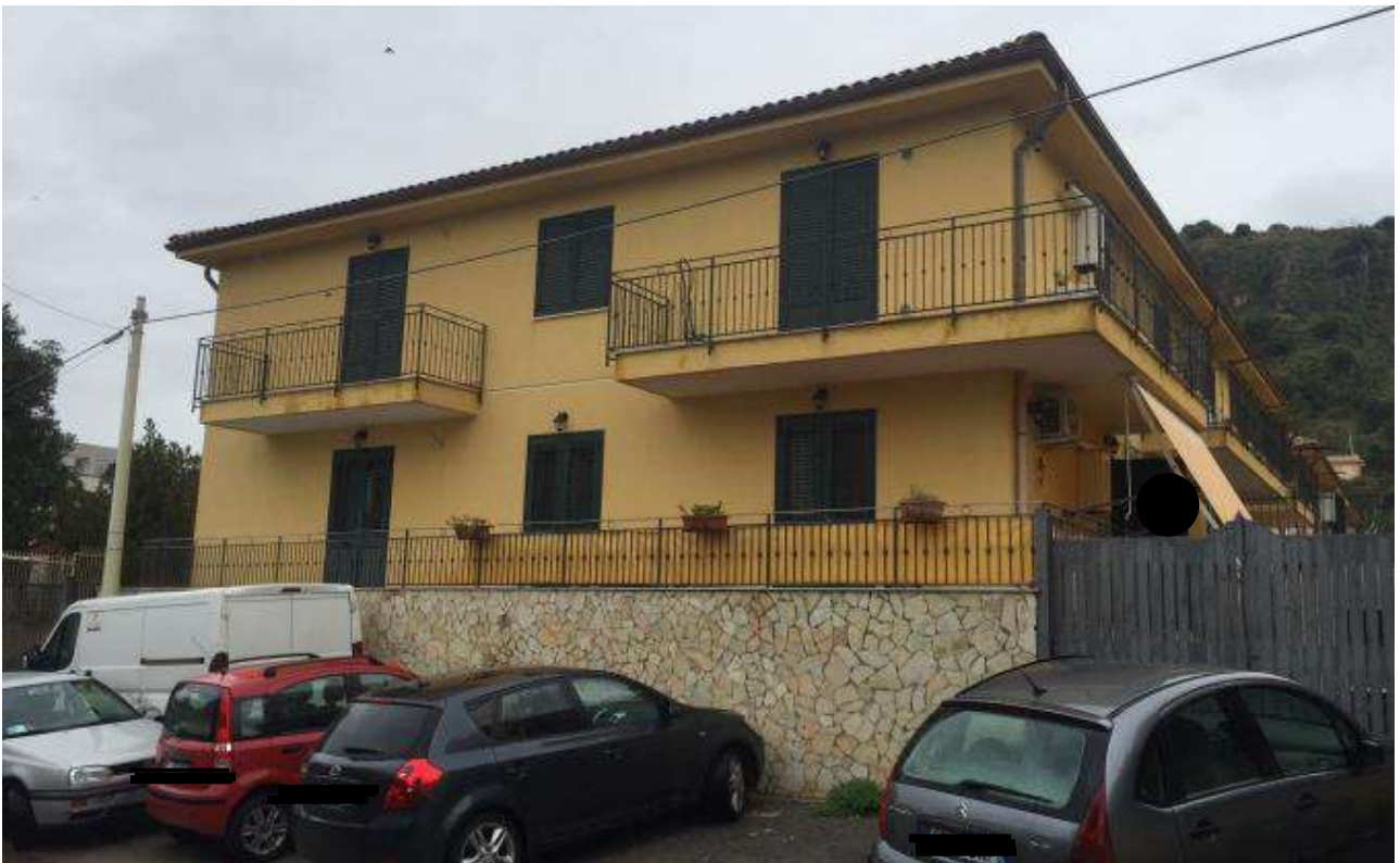
Foto n. 4 – Prospetto sulla via Sant’Elia: corpo di fabbrica A
