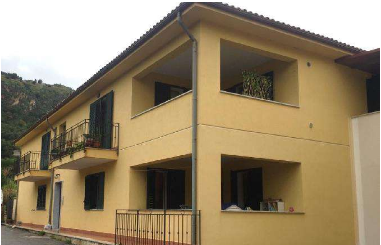
Foto n. 6 – Corpo di fabbrica "B"
