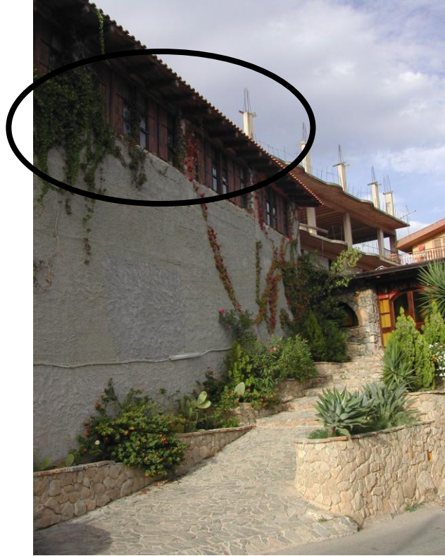
Foto 7 – Prospetto sulla Strada Provinciale
