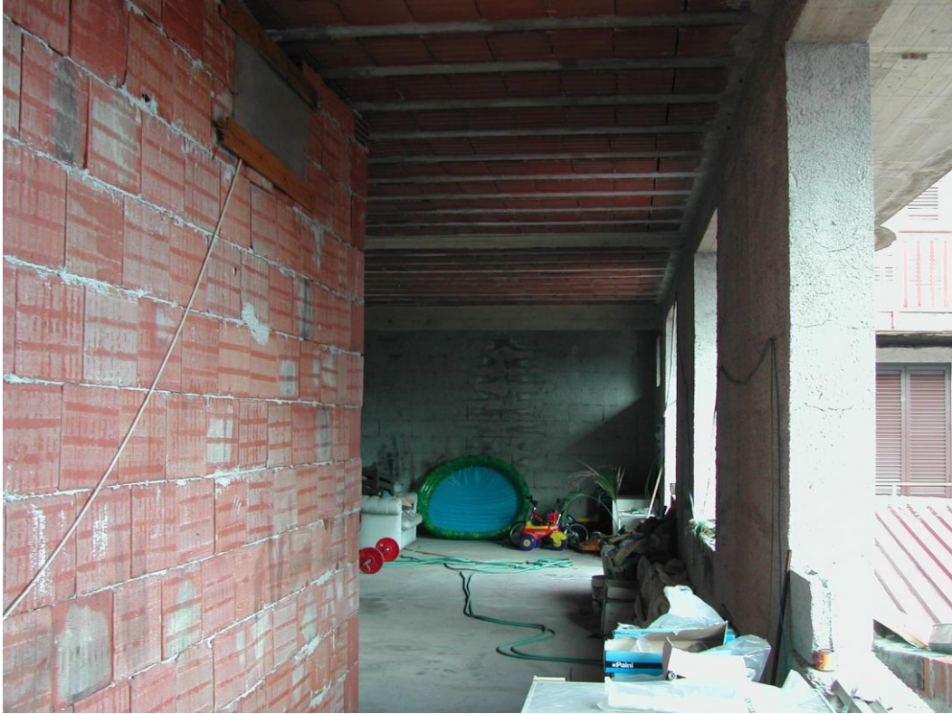
Foto 7 – Corridoio di collegamento al piano terra con la pizzeria
