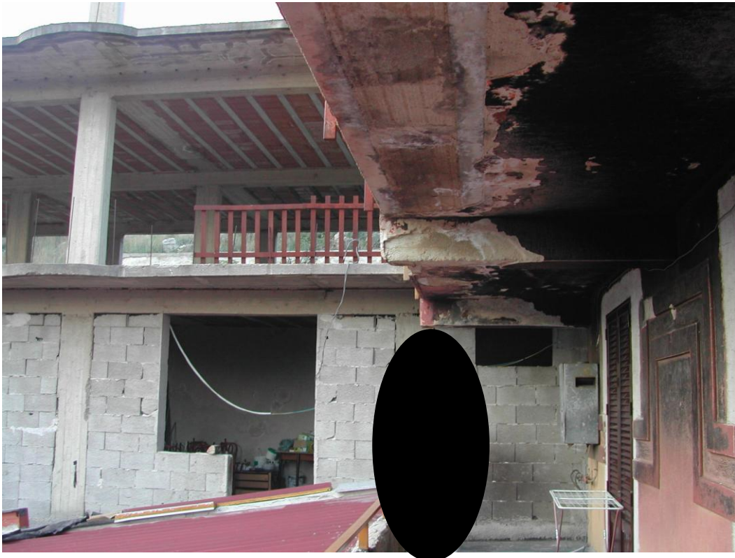
Foto 5 – Vista del prospetto principale dal balcone della villa adiacente in uso
