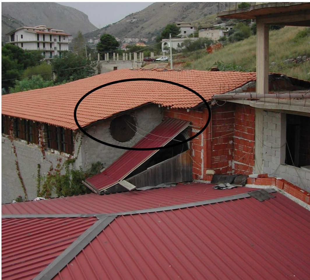
Foto 3 – Copertura e edifici adiacenti
