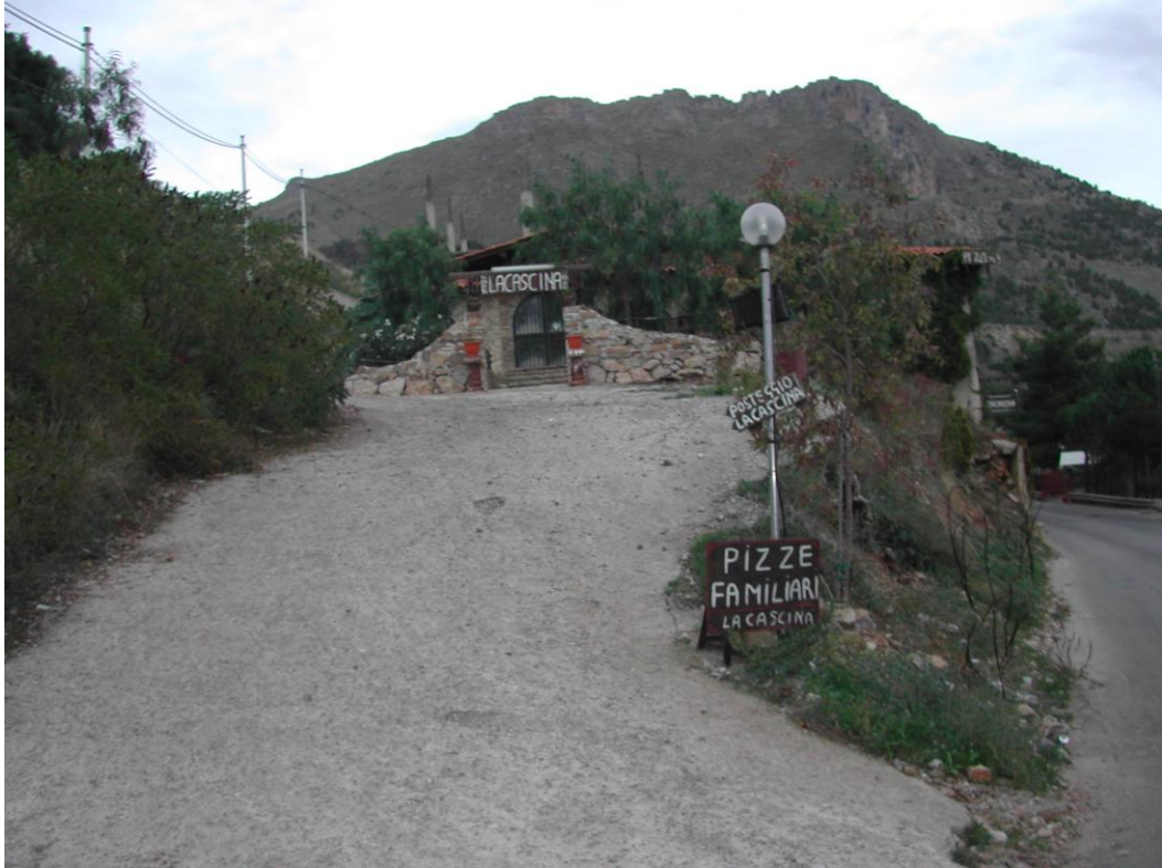
Foto 5 – Rampa di accesso
