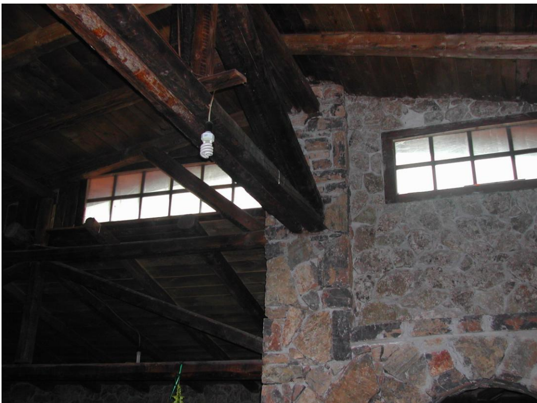
Foto 12 – Copertura con capriate in legno
