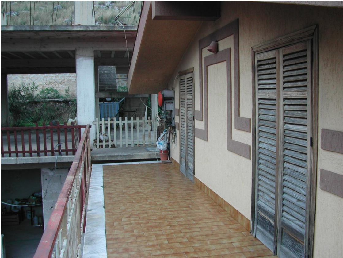
Foto 33 – Balcone sul prospetto laterale al piano 2
