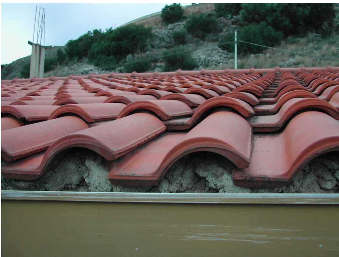
Foto 32 – Copertura con coppi dell'edificio
