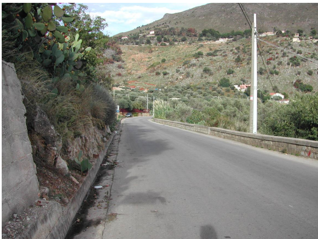
Foto 2 – Strada Provinciale da cui si accede all'immobile in esame
