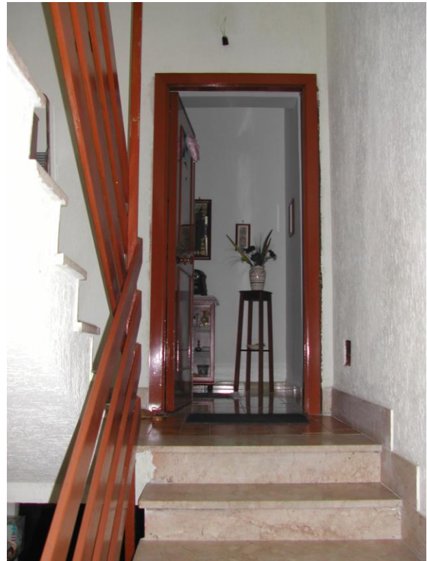
Foto 8 – Pianerottolo al primo piano
