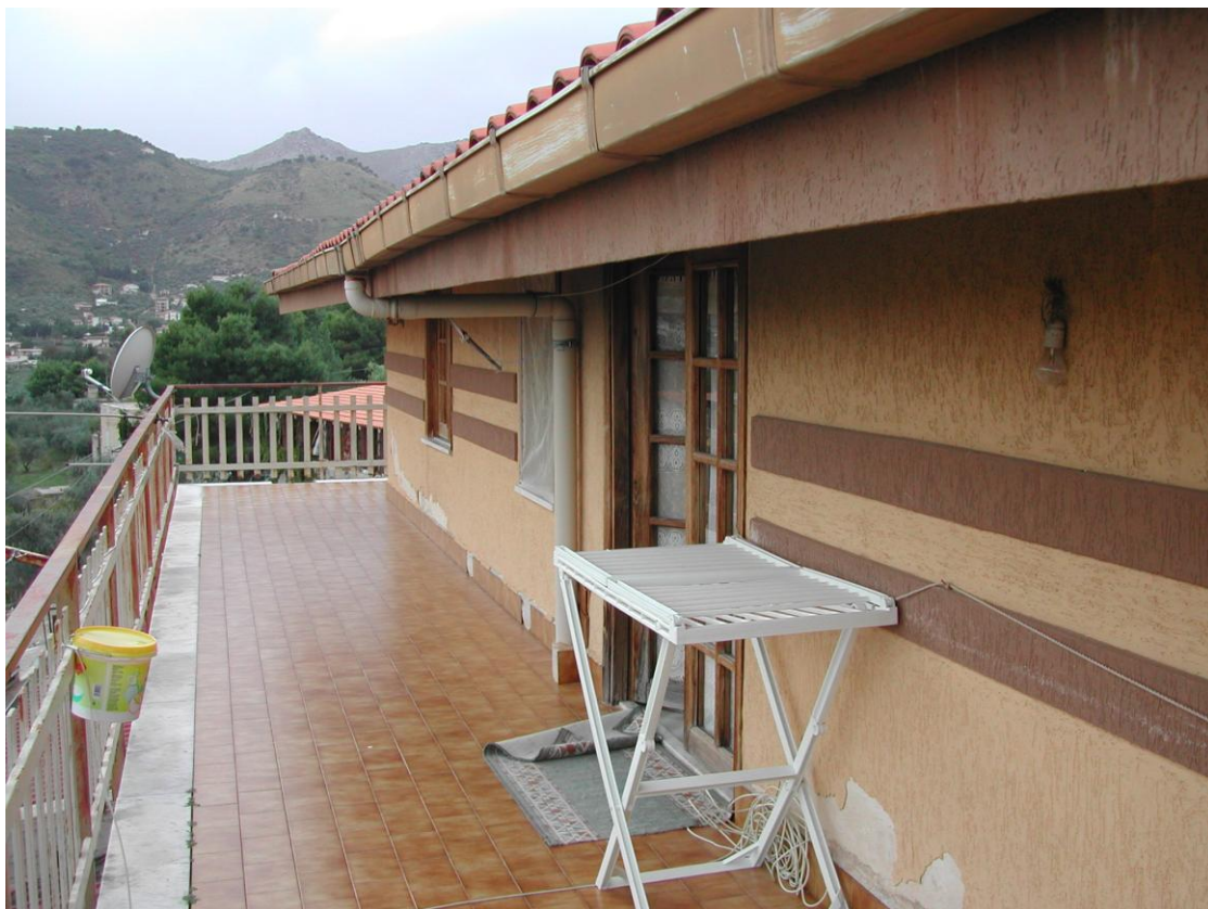
Foto 31– Balcone sul prospetto principale a piano 2
