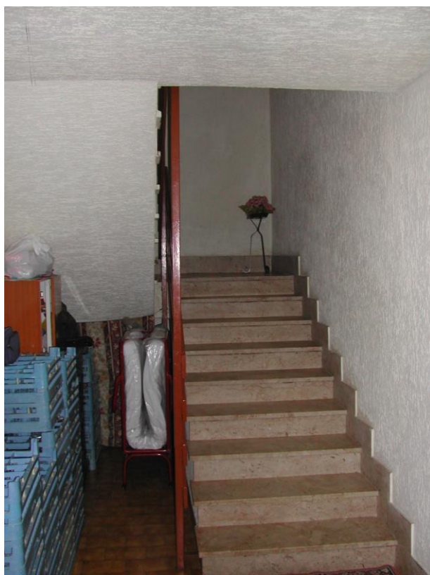
Foto 6 - Scala di accesso dal piano terra al piano primo
