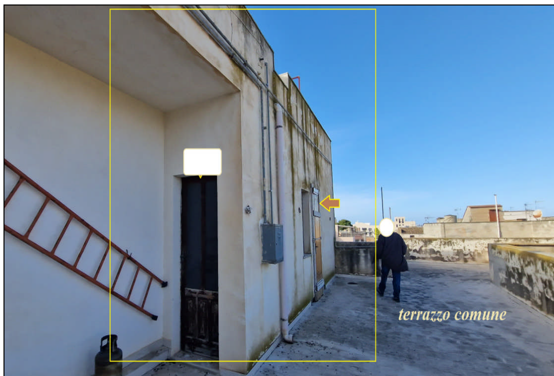
Foto 10: particolare vano Lavanderia piano terzo via delle Grazie 58 - Paceco.
