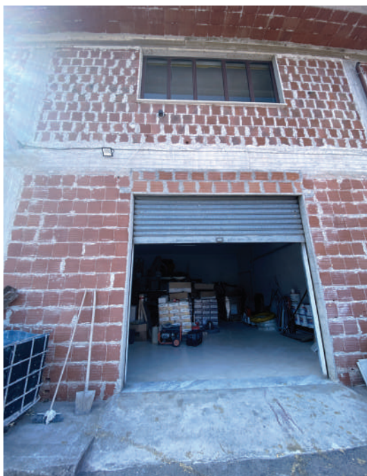
Foto 15. Accesso piano seminterrato.
