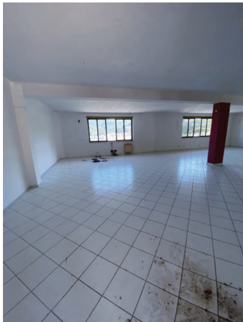
Foto 33. Porzione di piano terra adibita a magazzino/artigianale.
