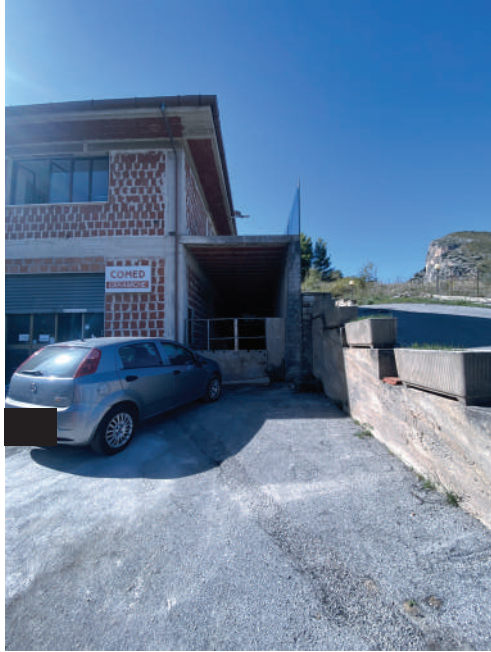
Foto 5. Piazzale piano seminterrato.
