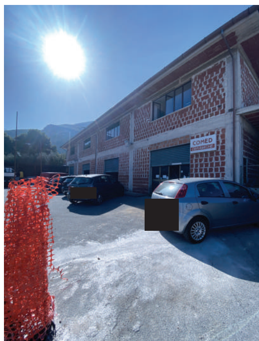
Foto 4. Piazzale piano seminterrato.
