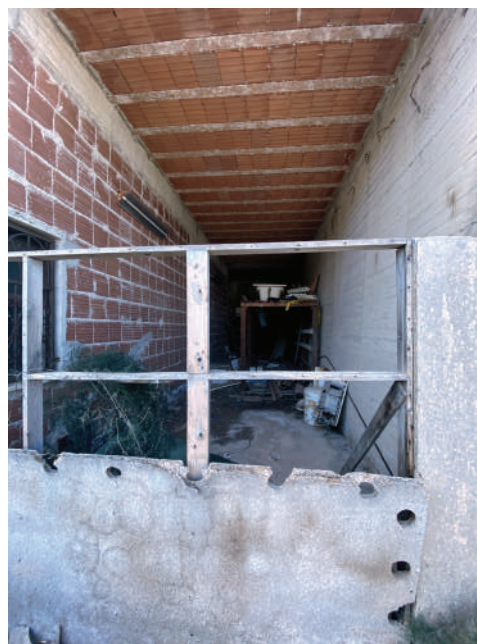
Foto 30. Piano seminterrato, porzione d'intercapedine chiusa.
