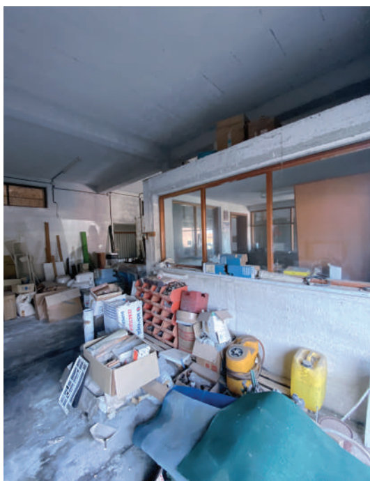
Foto 27. Piano seminterrato, Vano 3.
