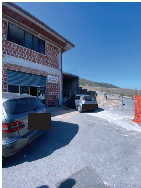
Foto 29. Piano seminterrato, piazzale.
