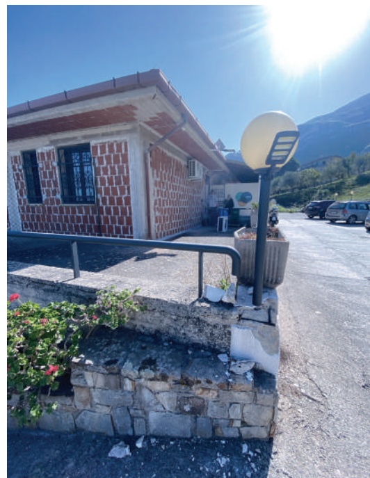
Foto 8. Prospetto laterale e piazzale piano terra.
