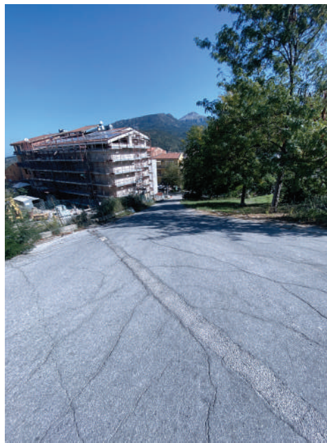
Foto 2. Strada di accesso al lotto.
