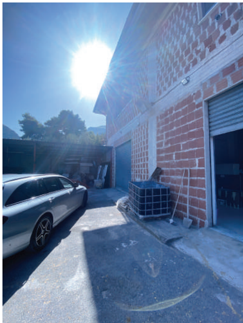
Foto 13. Accesso piano seminterrato.
