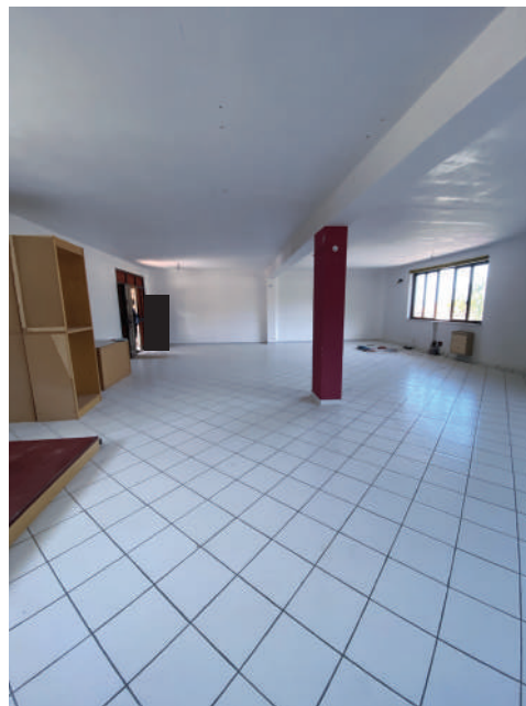
Foto 34. Porzione di piano terra adibita a magazzino/artigianale.
