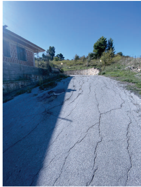
Foto 6. Strada di accesso al lotto.
