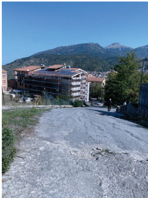
Foto 1. Strada di accesso al lotto.
