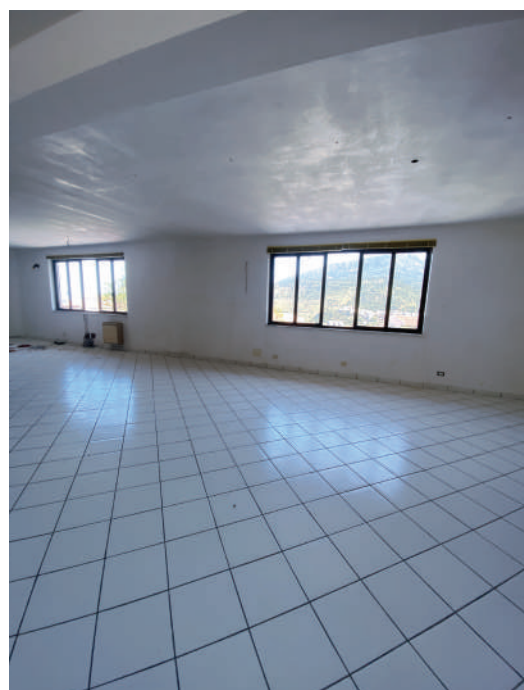
Foto 36. Porzione di piano terra adibita a magazzino/artigianale.
