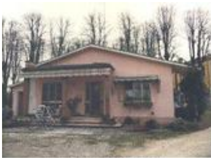
Foto 27: abitazione facciata Dvest
