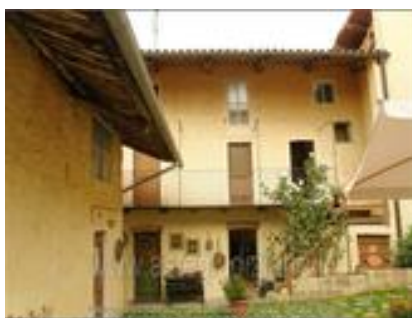
FABBRICATO PRINCIPALE - fronte est
