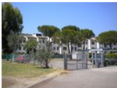
VISTA DA VIA SARDEGNA DEL COMPLESSO EDIFICIO
