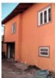
FABBRICATO PRIMO A SUD DEL CORTILE
