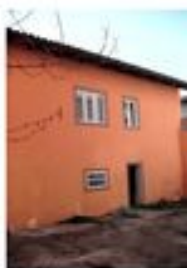
FABBRICATO SECONDO A SUD DEL CORTILE
