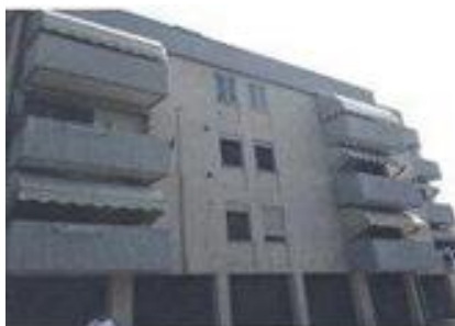
Foto 2: esterno: facciata Sud verso Est
