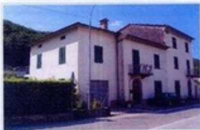
Vista del Fabbricato Principale della Via del Brennero
