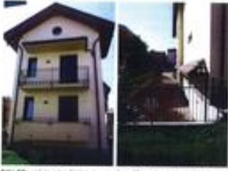
Foto 02 - veduta retro fabbricato Foto 03 - veduta laterale fabbricato
