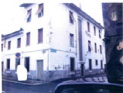
Foto del fabbricato da via S. Michele angolo Via Torio
