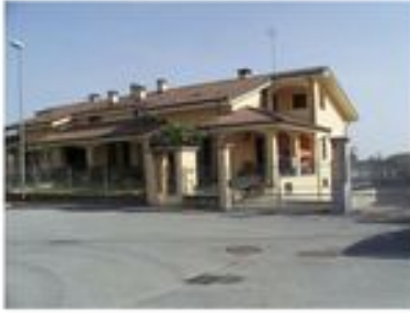
Esterni fabbricato Facciata principale
