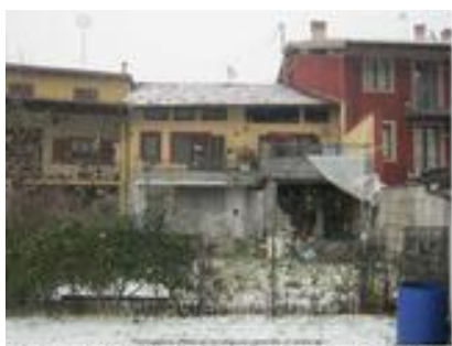
foto 4: vista del fabbricato e dell'area di pertinenza
