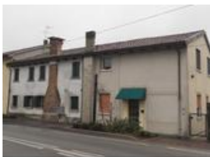
FRONTE STRADA LOTTO N. 1 E 2
