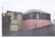
Foto del locale da via S. Marco
