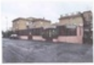
Foto del locale da via S. Marco
