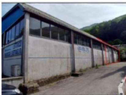
Foto 1 - Vista del fabbricato artigianale
