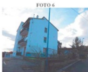
vista lato strada
