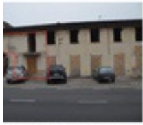
Fotografia 2 - Prospetto da Via Marconi lotto n. 2
