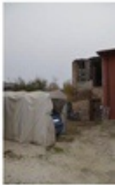
Fotografia 3 - Prospetto rustico annesso al lotto
