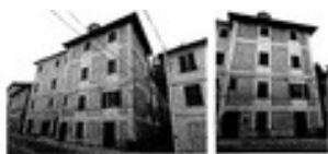
Foto 1: Prospetto Est e Nord
