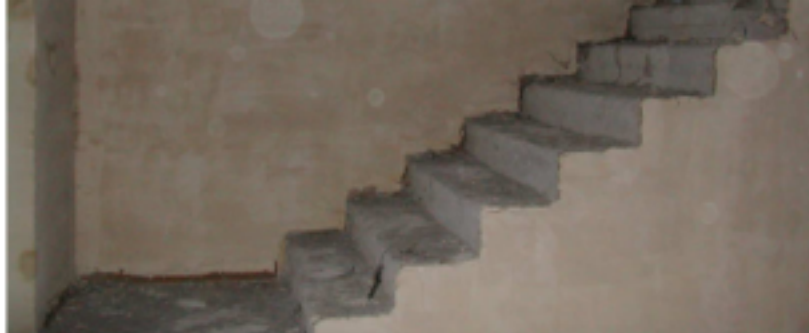
Scale d'accesso al piano interrato
