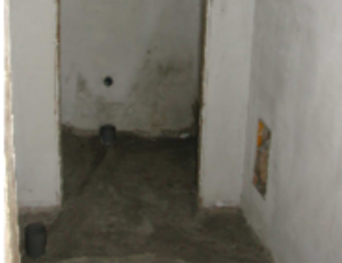
Locale a piano terra interno w.c.
