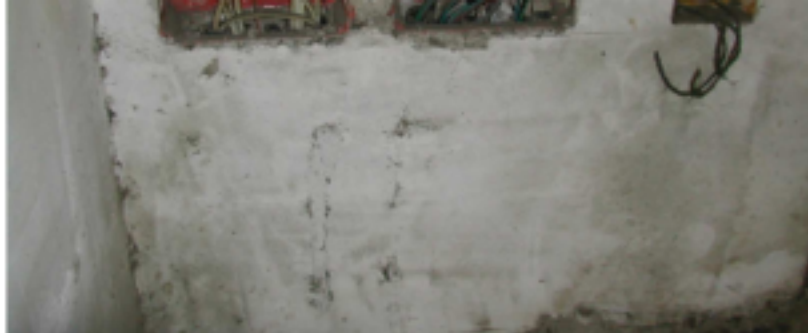
Locale a piano terra impianto elettrico
