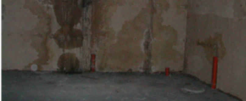
Secondo locale a piano interrato
