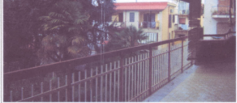
Balcone lato ovest
