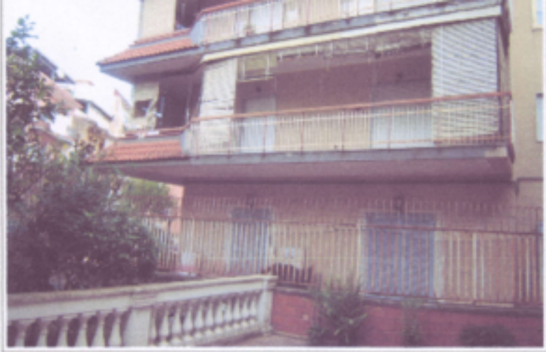
Balcone lato ovest visto dal cortile
