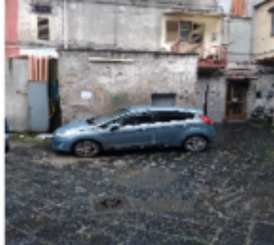
Foto n° 2 – Piano terra altra veduta esterna del locale magazzino.
