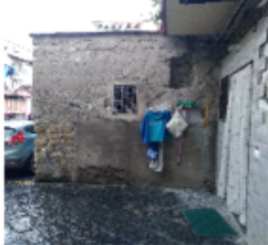
Foto n° 1 – Piano terra veduta esterna del locale magazzino.
